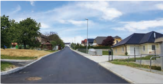
Ulica je dobila nov asfalt.
